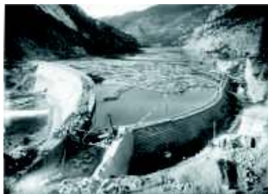
Maderada durante la construcción de la presa en 1909
